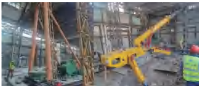
室内桩基施工
