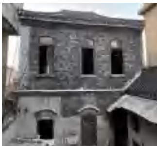
图1 修复前立面照片
