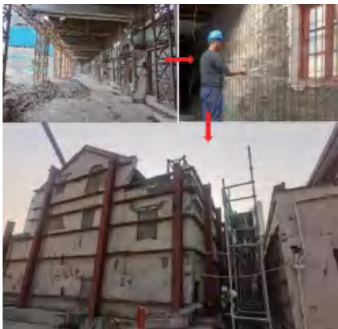
内部拆除及加固
