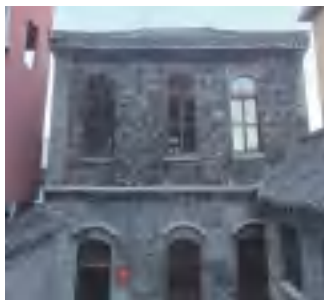
图2 修复后立面照片
