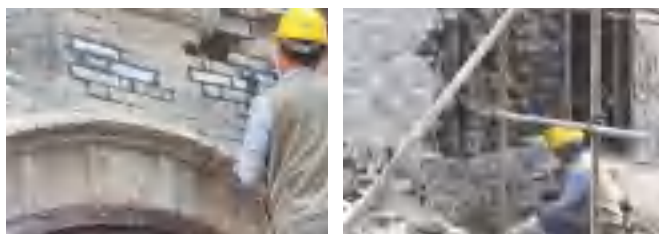
图7 墙体修缮施工照片
