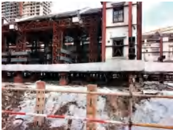
文保建筑提升完成后现场实况
