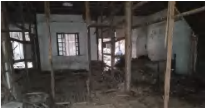
图3 现场木结构构件修缮前照片
