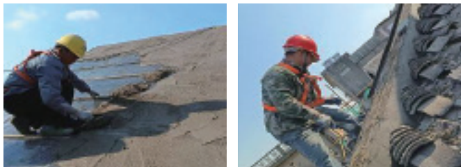
图6 屋面修缮施工照片
