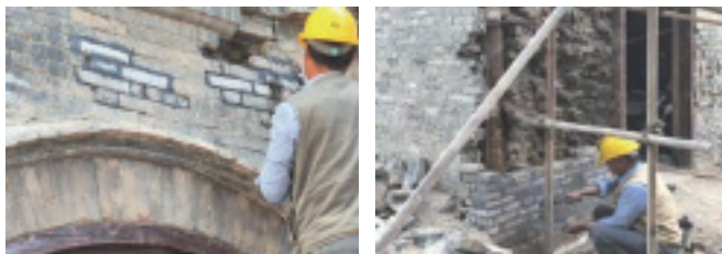
图7 墙体修缮施工照片
