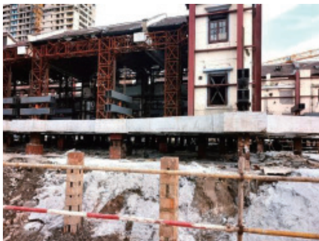
文保建筑提升完成后现场实况
