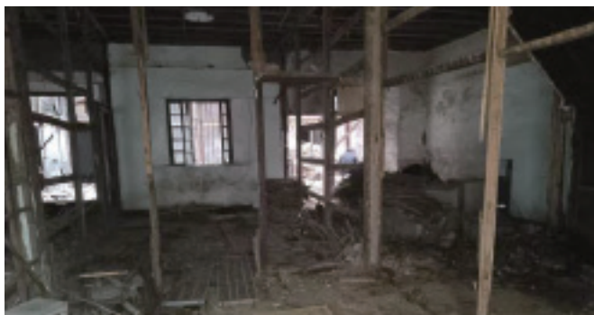
图3 现场木结构构件修缮前照片
