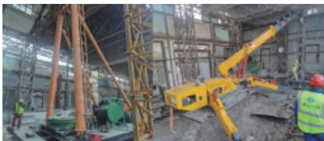
室内桩基施工
