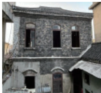
图1 修复前立面照片
