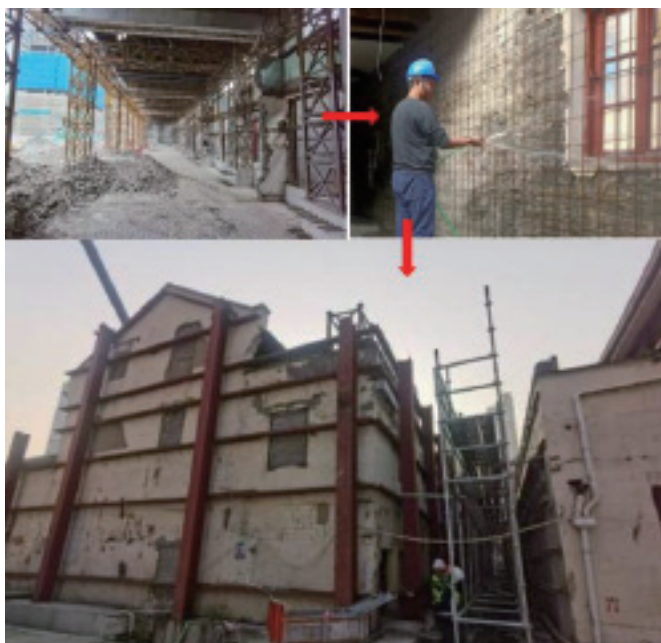
内部拆除及加固
