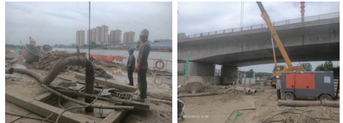
图3 气举反循环法二次清孔图
