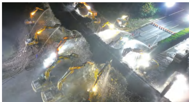
党员突击队攻坚：12小时拆除高速互通匝道桥
