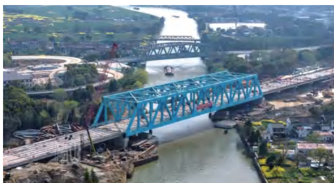
承建的全国最大跨径公路简支钢桁梁桥半幅安装成功
