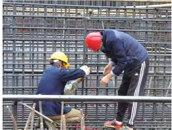
图4 自主研发的埋入式传感器固定卡设计与现场安装
