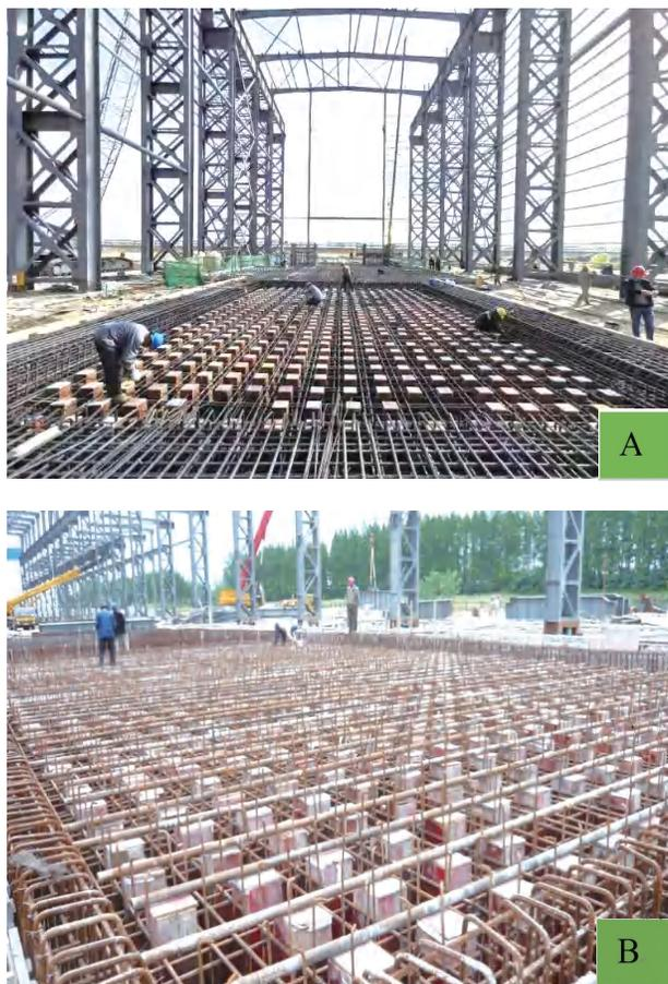
图3 预留洞口模板安装和抗浮施工
