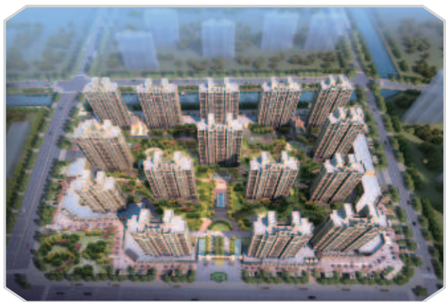
郯城县政府片区安置房EPC项目 (设计采购施工总承包)
