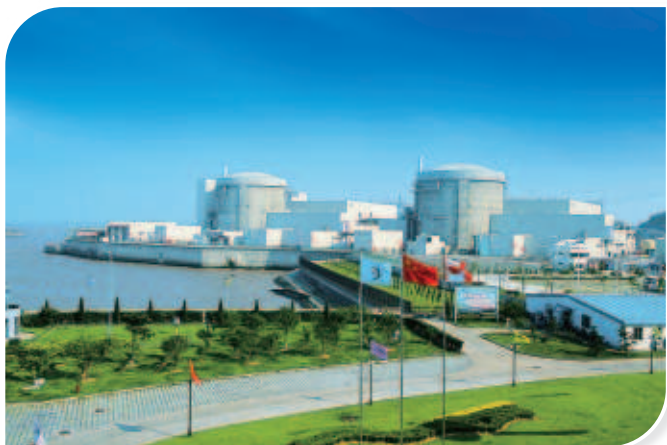
浙江泰山核电站(三期)重水堆建筑工程(鲁班奖)
