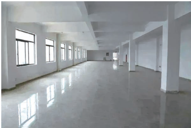
项目4号厂房规范的地砖贴面和棱角分明梁柱观感
