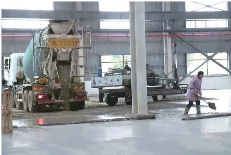
施工人员浇筑金钢砂地坪
